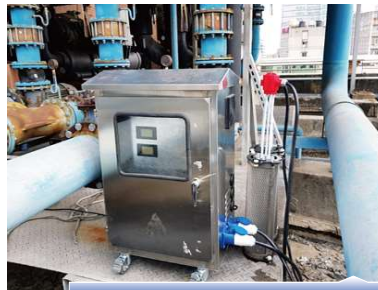
主機電源安裝
