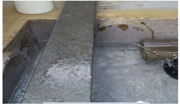
冷卻塔清洗完成
