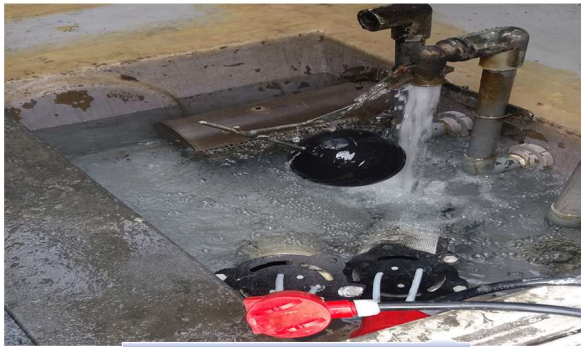
設備安裝投入使用
