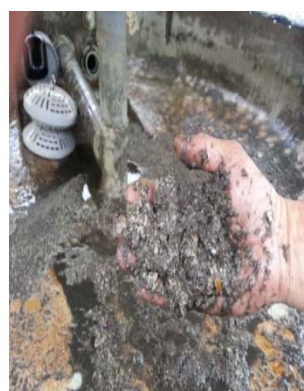
➡ UT303 投放 14 天后，散熱鰭片水垢剝落 冷卻水塔排放大量溶解成細砂及水垢
