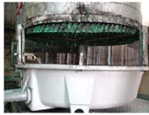
散熱材塌陷
