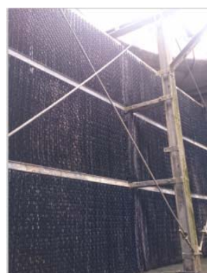
➡ UT303 投放 14 天后，散熱鰭片水垢剝落 冷卻水塔排放大量溶解成細砂及水垢
